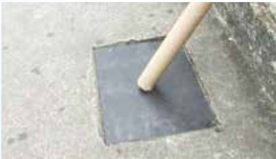
Colocação de tampa provisória em caixa de passagem da Rua XV de Novembro - Centro
