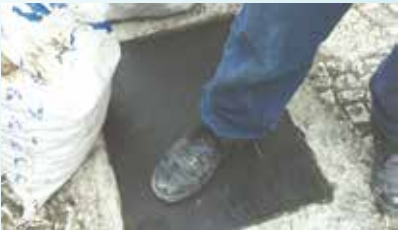
Colocação de tampa provisória na Rua Gonçalves Dias - Centro
