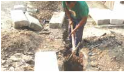
Colocação de meio fio para posterior calçamento na rua principal - Monte Cabráo Programação 14/10
