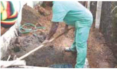
Construção de caixa de esgoto no setor de obras - Caruara
