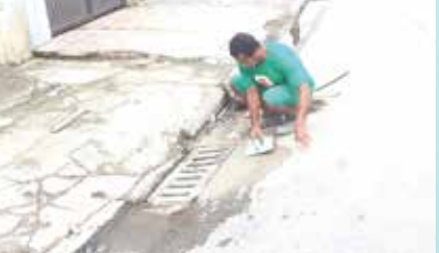
Troca de grelhas na Avenida Brigadeiro Faria Lima - Rádio Clube
