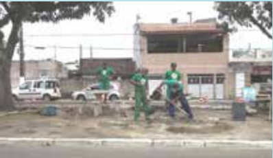
Colocação de mesas e banquetas de concreto na Avenida Afonso Schmidt - Rádio Clube
