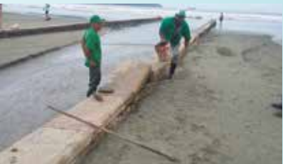
Reparo na mureta de pedra do canal 4 - Embaré
