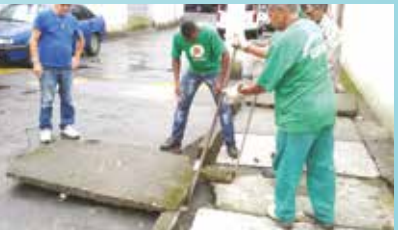
Troca de tampas de drenagem danificadas na Rua Coronel Galhardo - Nova Cintra
