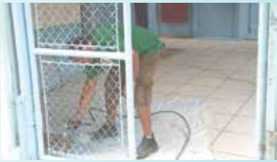
Reparo no portão da UME Judoca Ricardo Sampaio - Caruara
