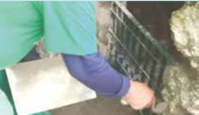
Instalação de gradil metálico na Gruta Santa Casa - Fontana
