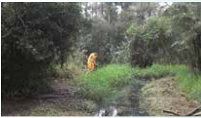
Limpeza e desobstrução de vala da Rua Trusilva - Caruara
