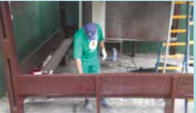
Continuação de pintura na UBS Vila Progresso
