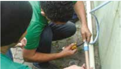
Instalação hidráulica na Arena Santos - Vila Mathias
