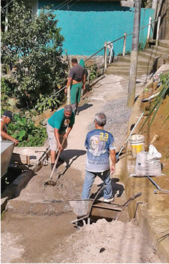
Recuperação de escadaria - Jabaquara
