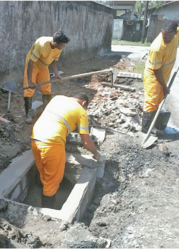
Serviços de construção de caixa de drenagem na Rua Três - Caruara
