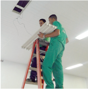
Manutenção elétrica para troca de lâmpadas e reatores no Departamento de Gestão de Tecnologia de Informação e Comunicações (Detic)
