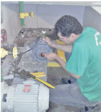
Manutenção da moto bomba de recalque da caixa d'água do prédio da Rua Dom Pedro II
