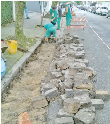
Renivelamento de sarjeta em paralelepípedos na Rua Pasteur
