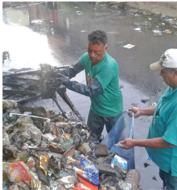
Limpeza de canal na Travessa Gemma Rebello
