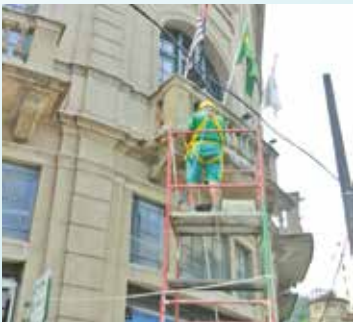
Retirada de reboco para reparo nas sacadas do prédio da Rua Dom Pedro II - Centro
