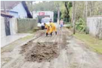
Serviços de limpeza e renivelamento de ruas - Caruara
