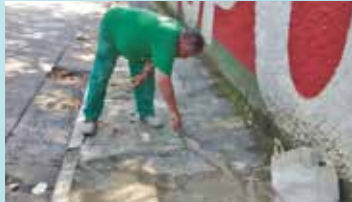
Reparo de concreto em calçada na Av. Antonio Manoel de Carvalho - Nova Cintra
