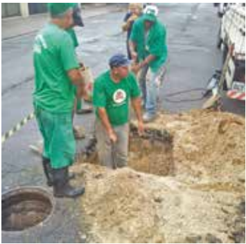
Reparo em abatimento na Rua Nabuco de Araújo - Orla
