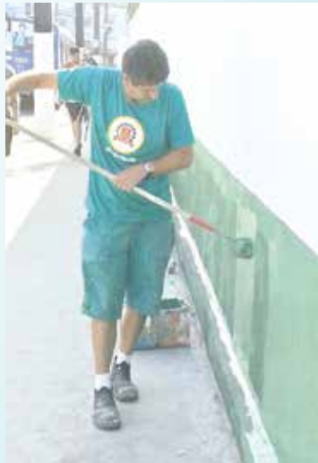
Acabamento nos pilares do quiosque na Praça Otávio Ribeiro de Araújo - Vila São Jorge
