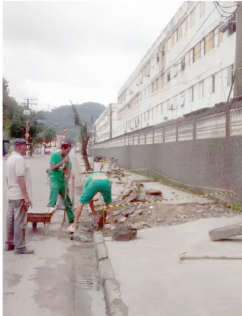
Recuperação de alambrado na área de skate na Av Afonso Schmidt - Castelo
