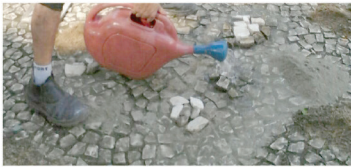
Continuação do assentamento dos pisos de mosaico português na Praça dos Andradas
