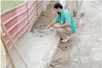
Concretagem da calçada da rua principal - Monte Cabrão
