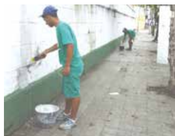
Pintura da fachada do Cemitério do Paquetá
