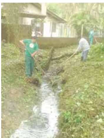
Roçada e limpeza da vala de drenagem ao lado da UME Noel Gomes Ferreira - Caruara
