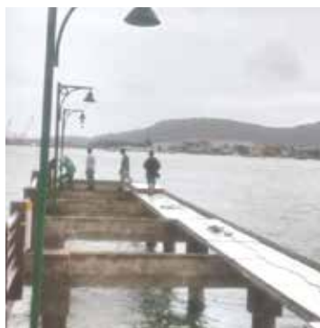
Retirada do guarda corpo danificado do Deck do Pescador - Ponta da Praia
