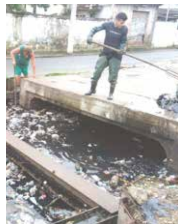
limpeza de canal na Av. Haroldo de Camargo - Castelo
