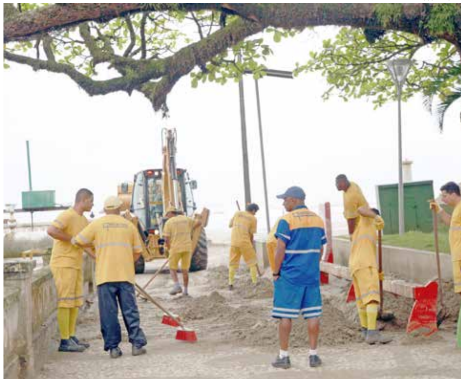
Cinco equipes contendo nove pessoas cada estão trabalhando na limpeza manual
