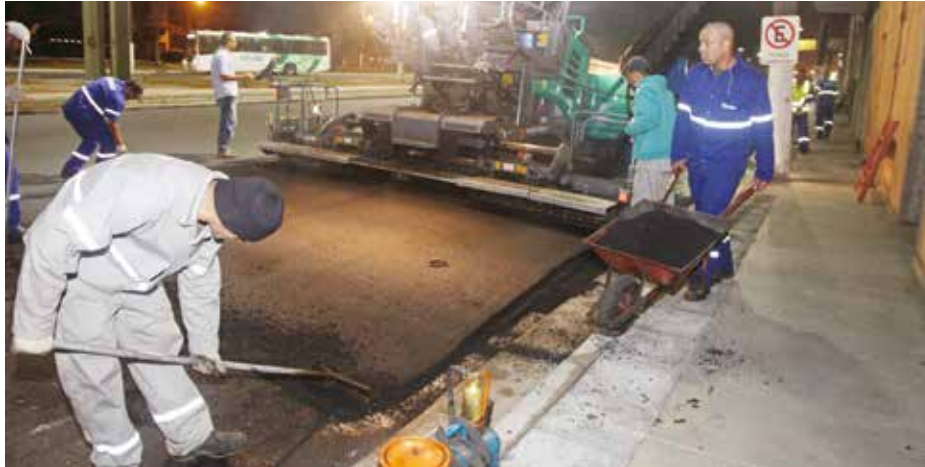
Operários aplicaram asfalto entre a Rua Cristiano Ottoni e a Travessa João Cardoso
