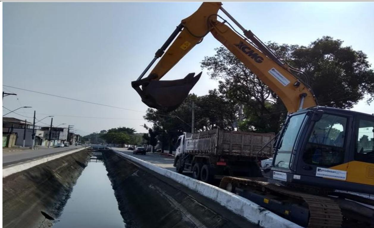
Foto 12 – Limpeza mecanizada de canal - Av. Hugo Maia - Zona Noroeste.
