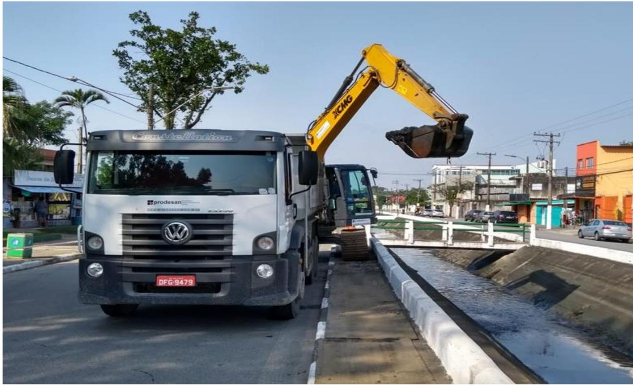
Foto 16 – Limpeza mecanizada de canal - Av. Hugo Maia - Zona Noroeste.
