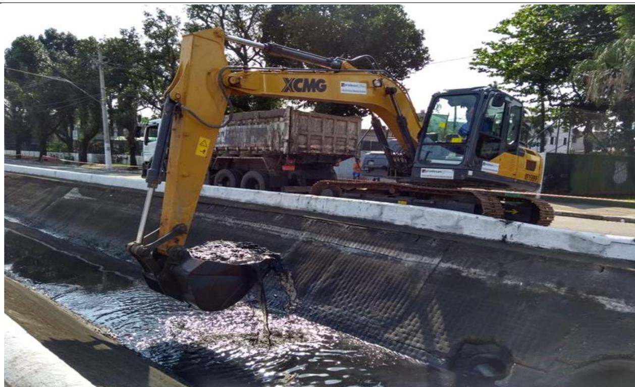
Foto 14 – Limpeza mecanizada de canal - Av. Hugo Maia - Zona Noroeste.
