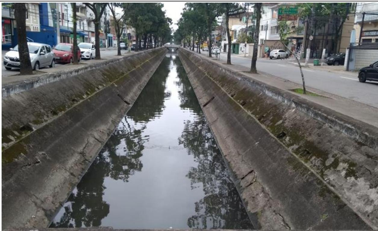
Foto 48 – Canal 1 – Bags de retenção de sólidos instalados em todos os canais. Limpeza realizada diariamente com equipamento "pulsá" - Praia do José Menino.
