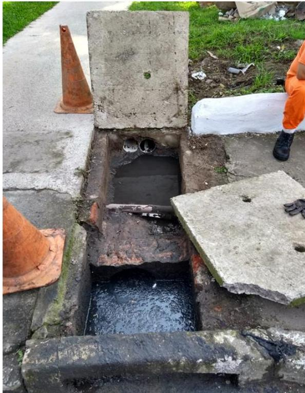
Foto 20 – Tampas de concreto para inspeção deste trecho coberto do canal. Jardim Castelo.
