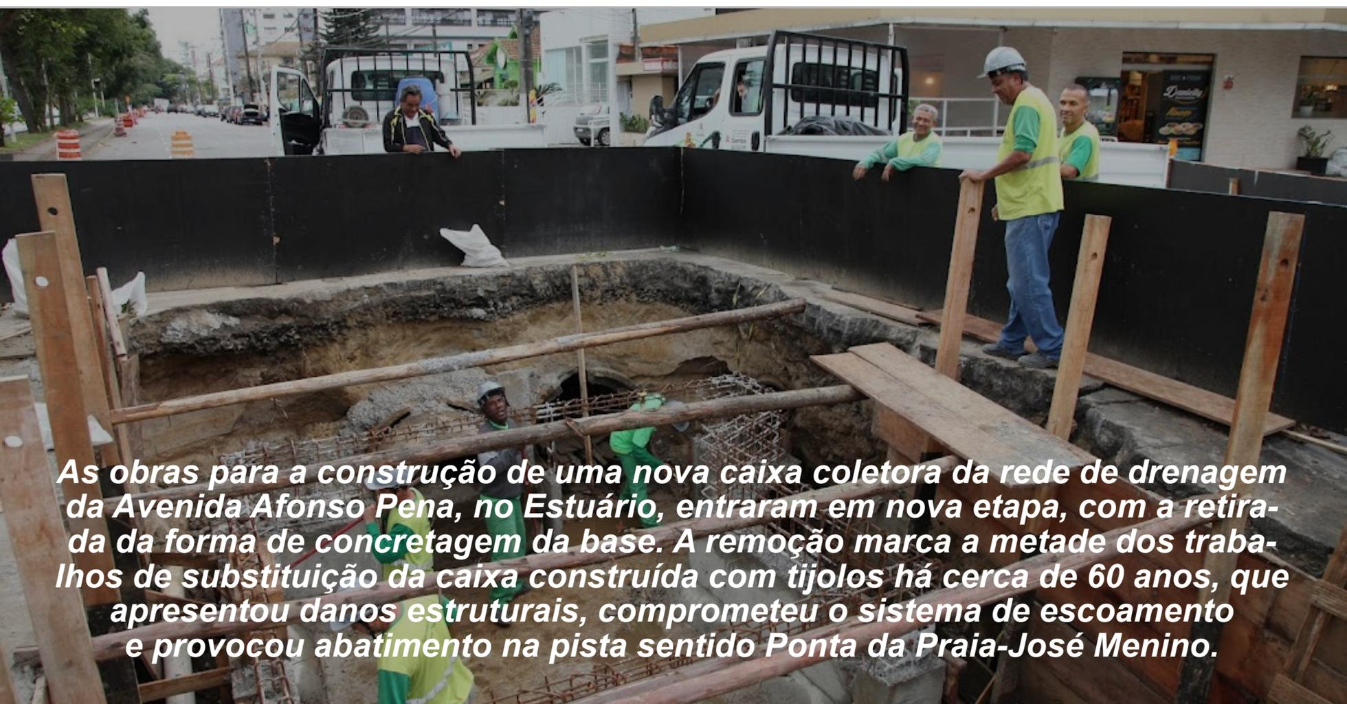
**As obras para a construção de uma nova caixa coletora da rede de drenagem da Avenida Afonso Pena, no Estuário, entraram em nova etapa, com a retirada da forma de concretagem da base. A remoção marca a metade dos trabalhos de substituição da caixa construída com tijolos há cerca de 60 anos, que apresentou danos estruturais, comprometeu o sistema de escoamento e provocou abatimento na pista sentido Ponta da Praia-José Menino.**
