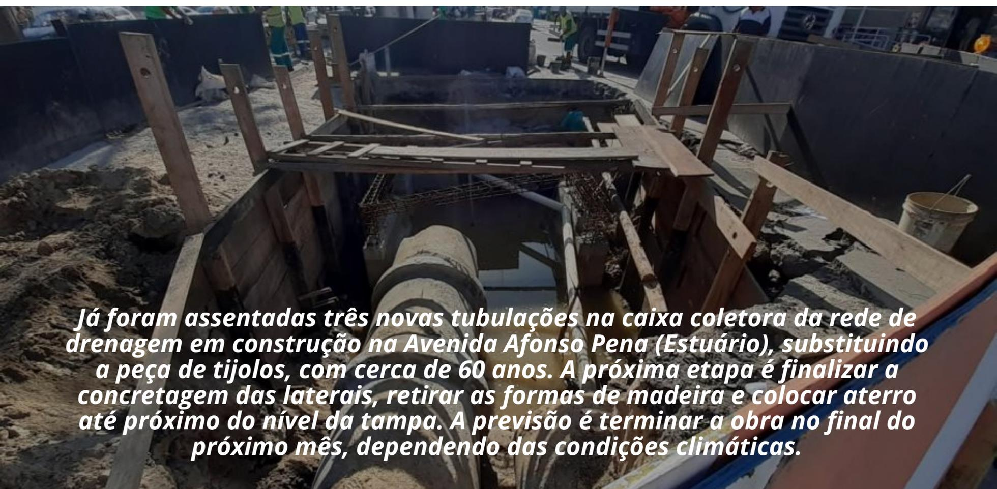
***Já foram assentadas três novas tubulações na caixa coletora da rede de drenagem em construção na Avenida Afonso Pena (Estuário), substituindo a peça de tijolos, com cerca de 60 anos. A próxima etapa é finalizar a concretagem das laterais, retirar as formas de madeira e colocar aterro até próximo do nível da tampa. A previsão é terminar a obra no final do próximo mês, dependendo das condições climáticas.***
