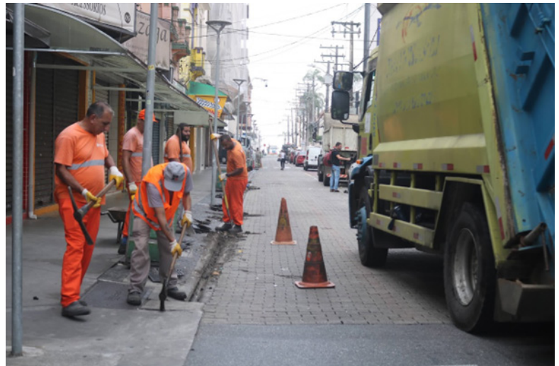
Sepref inicia amplo serviço de drenagem em vias do Gonzaga
