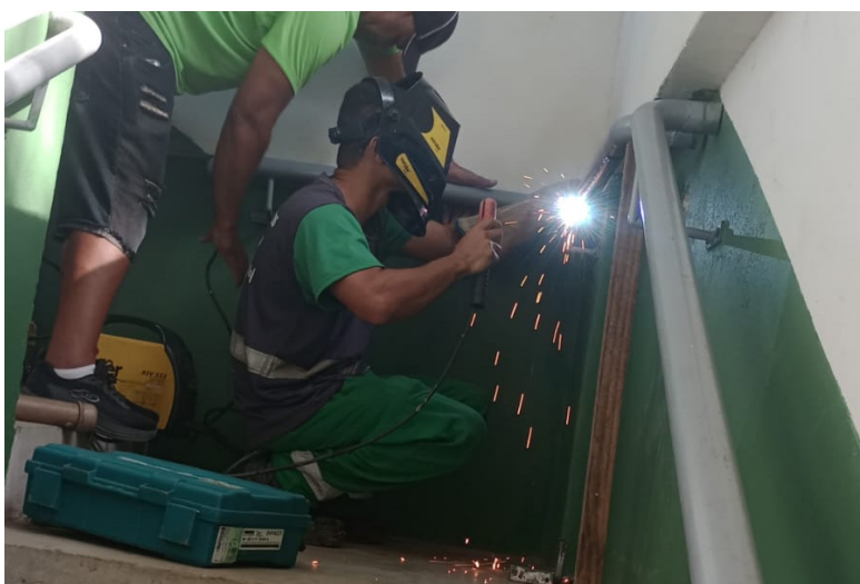
Reparos nos corrimãos da Torre de observação de pássaros
