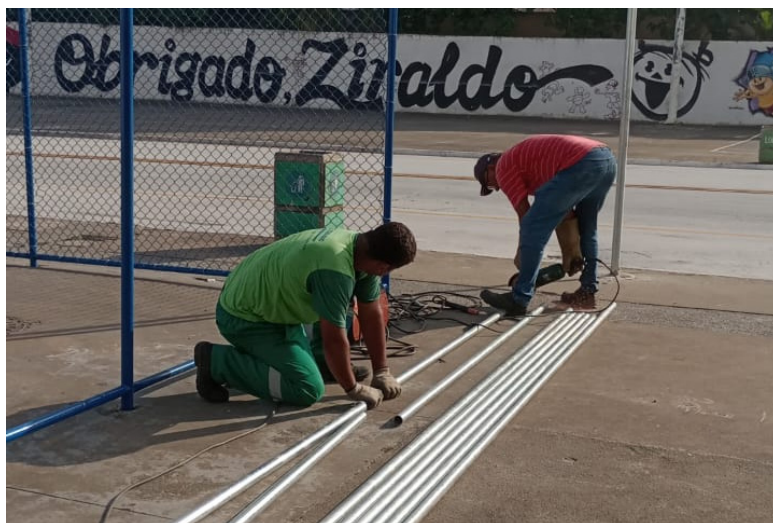
Instalação de tubos no alambrado da quadra esportiva na Areia Branca
