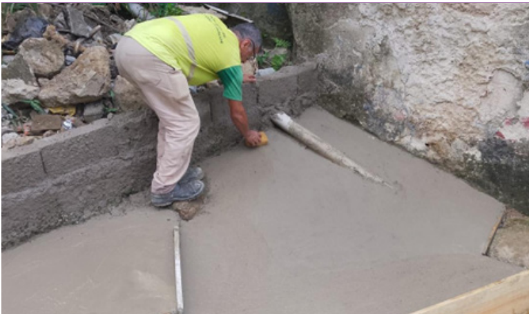
Recuperação de calçada no trecho Rua São Caetano x Rua Santo Amaro, no São Bento
