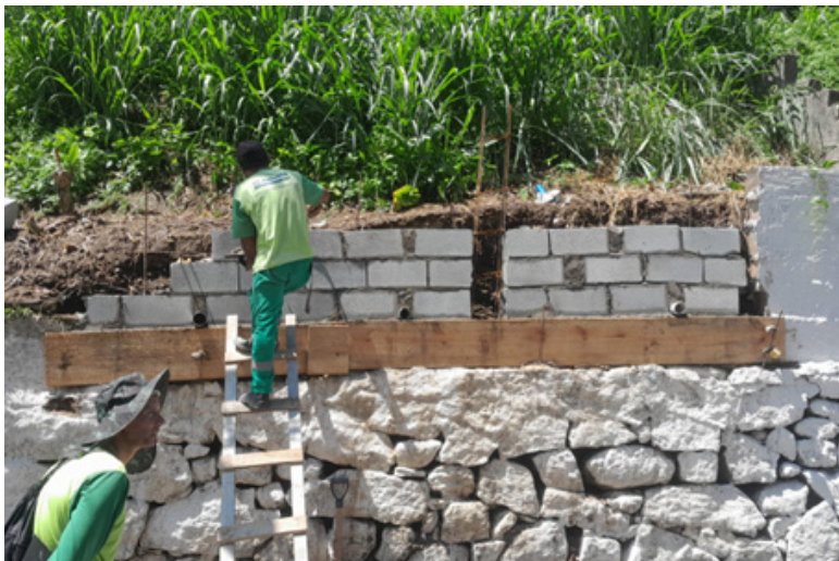
Demolição e reforma de muro na Av. Bandeirantes, Morro São Bento
