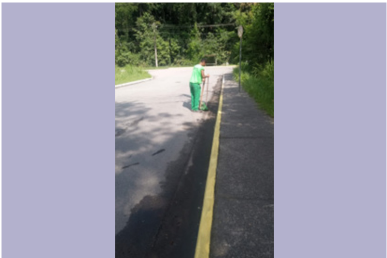
Vias do Monte Cabrão recebem pintura de guias
