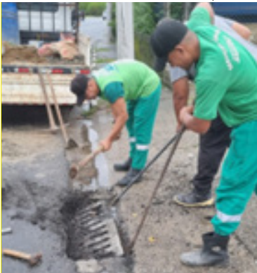
Deslacramento e substituição de bocas de lobo na Av. Martins Fontes
