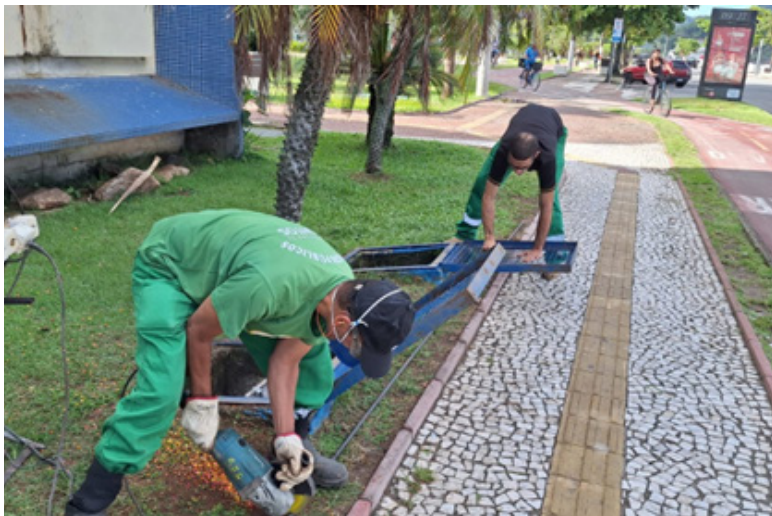
Aquário Municipal recebe reparos nas grades de proteção de refletores
