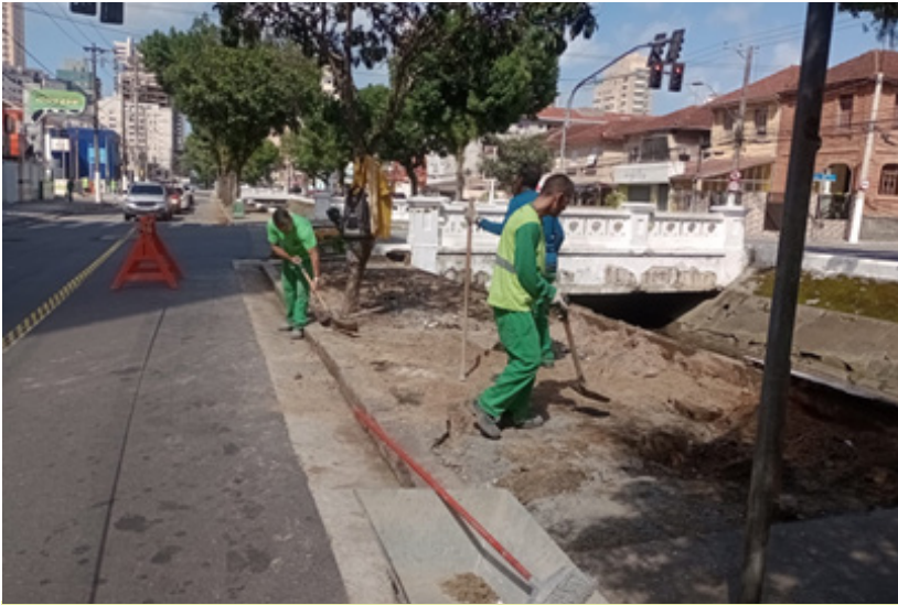
Reparo em calçada na Avenida Bernardino de Campos, na Vila Belmiro
