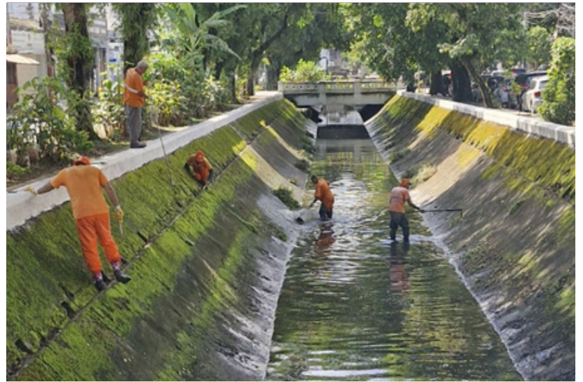
Manutenção e limpeza dos taludes do Canal da Avenida Siqueira Campos
