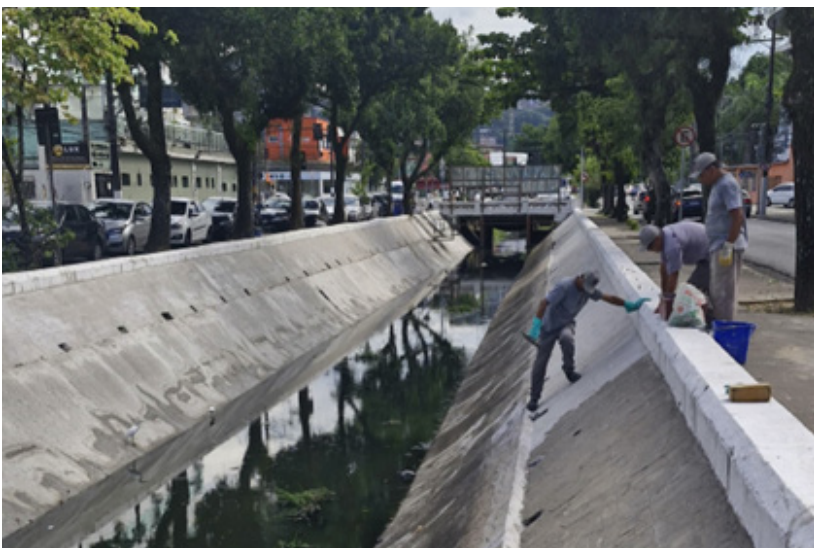
Restauração de talude do Canal da Avenida Bernardino de Campos
