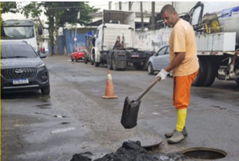
Serviço de drenagem na Rua Antônio Maia, no Macuco
