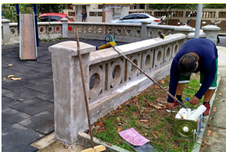
Serviço de pintura da Praça Waldemar Canellas, na Aparecida
