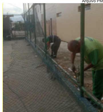
Início dos reparos de quadra esportiva na Última Ponte
