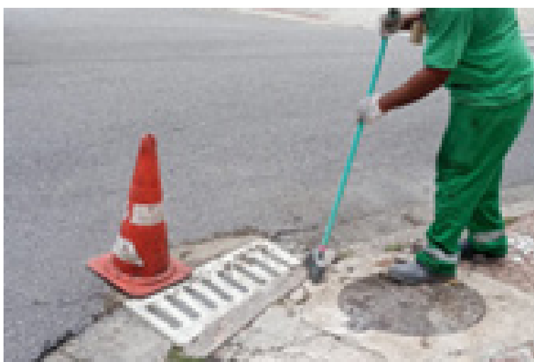
Troca de boca de lobo na Avenida Washington Luís, na Vila Mathias
