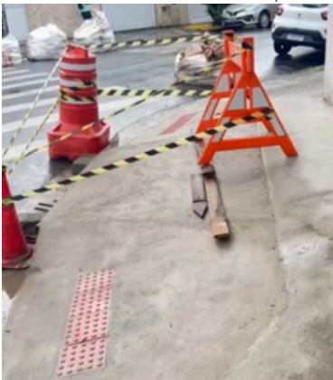
APARECIDA 1 Calçada na esquina da Alexandre Martins com a Liberdade recebe concretagem
