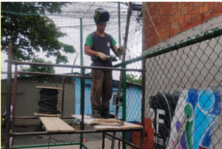
Ajustes nas telas e redes de proteção na quadra da Última Ponte
