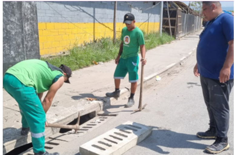
Reconstrução de caixa de limpeza e drenagem na Areia Branca
