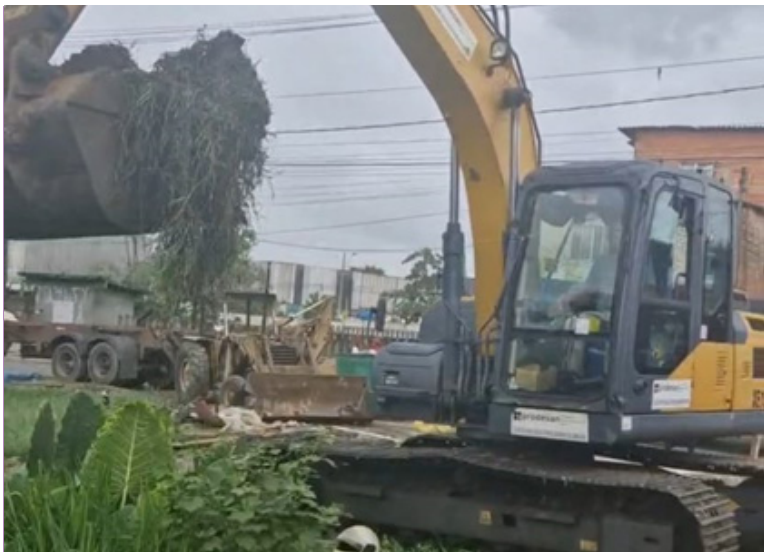
Desassoreamento mecânico no canal da Rua B, Vila dos Criadores, na Alemoa Industrial
