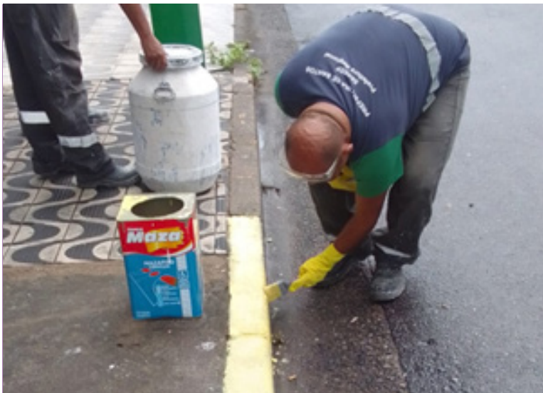
Prossegue a pintura de guias e sinalização do canteiro central da Avenida Pedro Lessa
