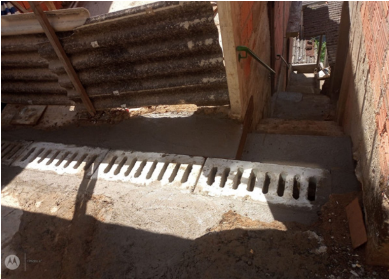
Pacheco: construção de caixas e instalação de grelhas com rede de drenagem na rua 10
