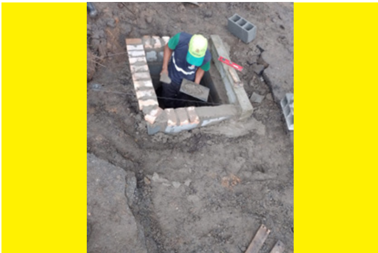
Confecção de caixa de passagem na rua Trusilva, no Quilombo
