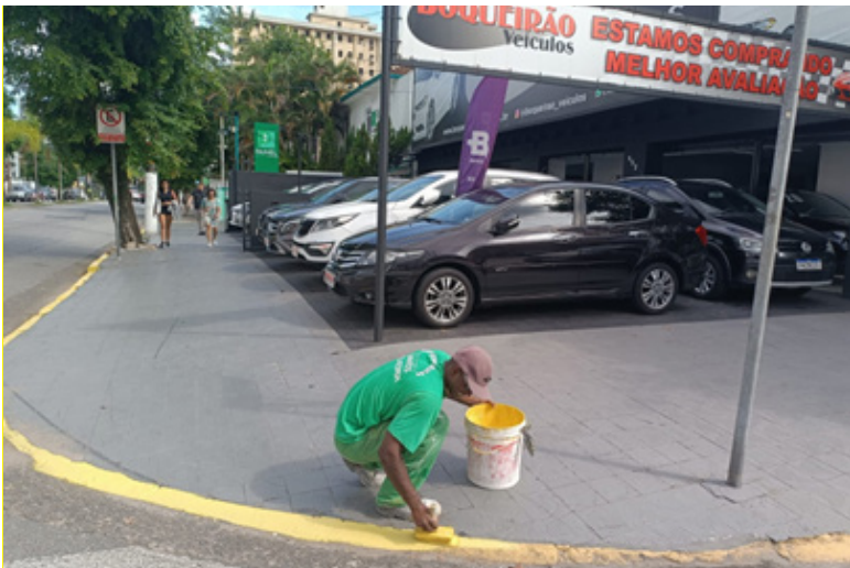
Pintura de guias na Avenida Conselheiro Nébias, no Boqueirão
