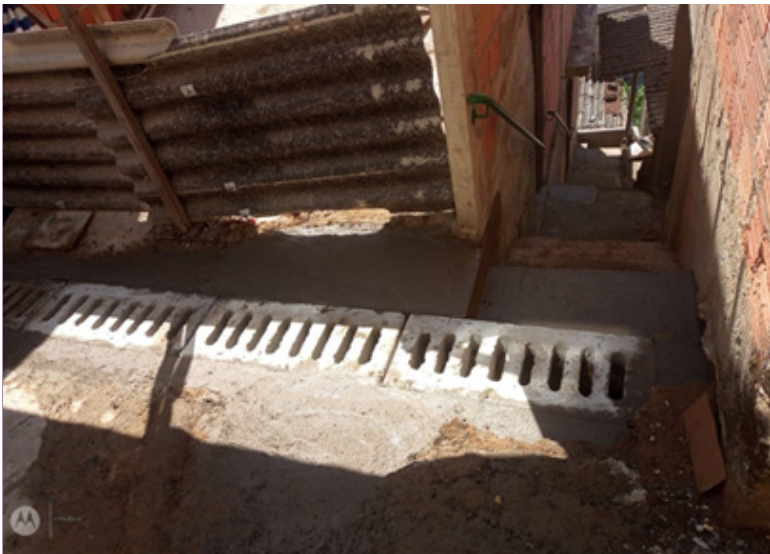
Construção de caixas e instalação de grelhas com rede de drenagem na rua 10, no Pacheco
