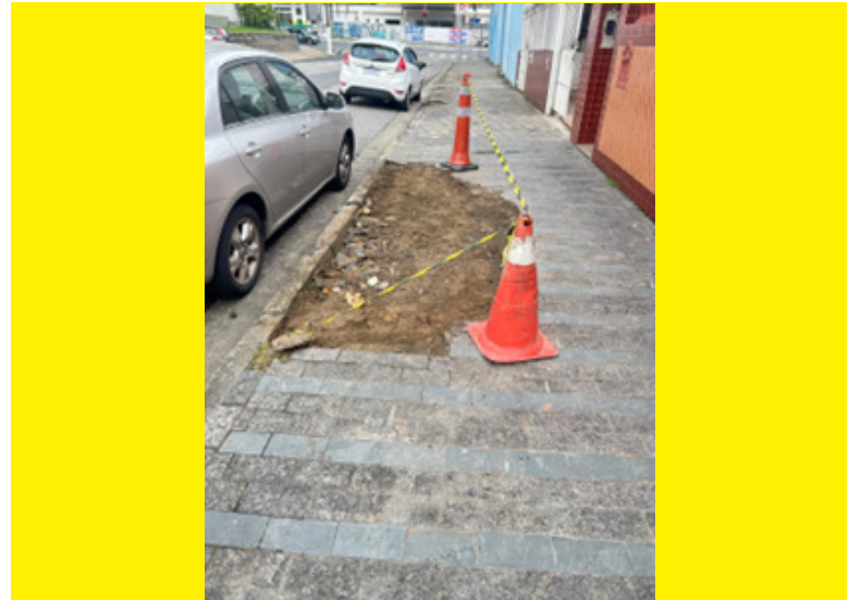
Intervenção em calçada da via Vasco da Gama, no Jabaquara
