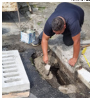
Boca de lobo é substituída na via Miguel Rocha Corrêa
