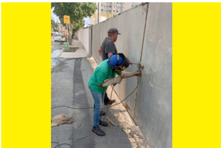
Centro Cultural da ZNO recebe serviços de solda e reparo
