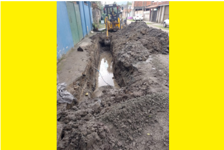
Instaladas manilhas na Rua Trusilva, no Quilombo
