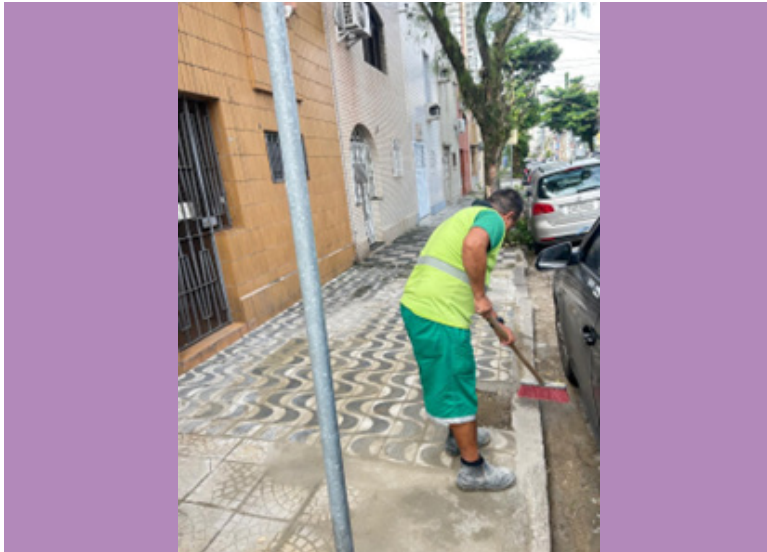
Calçada da Rua Teixeira de Freitas, no Campo Grande, recebe reparos
