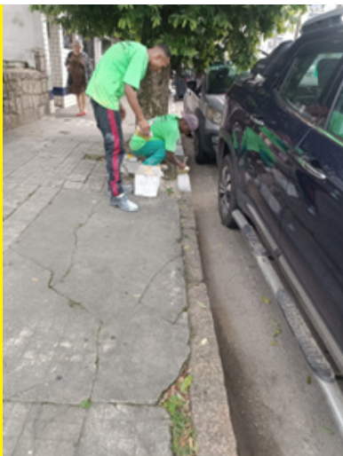
Prosseguem serviços de pintura na Avenida Ana Costa
