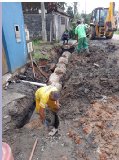
Quilombo: Instalação de manilhas continua na via Trusilva
