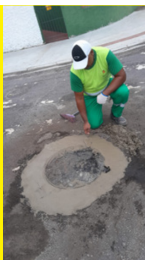
Nova tampa de PV na Liberdade com a Joaquim Montenegro
