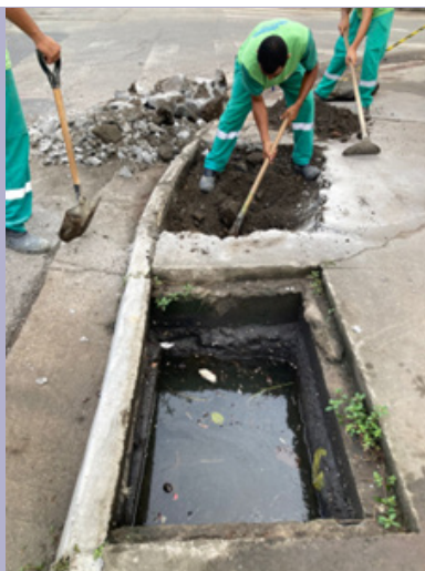
Instalação de tampa de concreto na Afonsina Proost x Santa Maria
