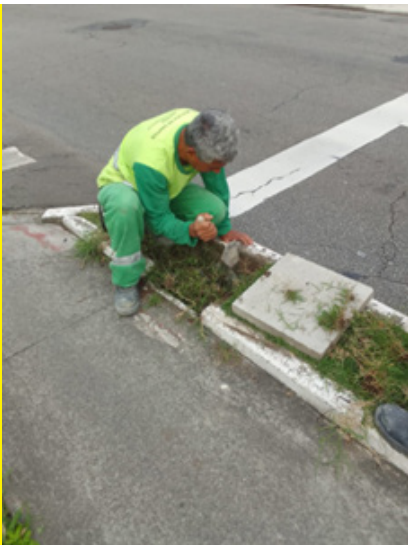
Avenida Ana Costa: reposição de tampa para caixa de passagem
