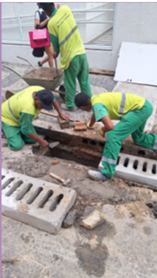
Bocas de lobo são instaladas na Alamir Martins, no Gonzaga
