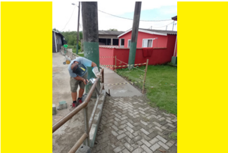
Instalação de guarda corpo na praça da Ilha Diana
