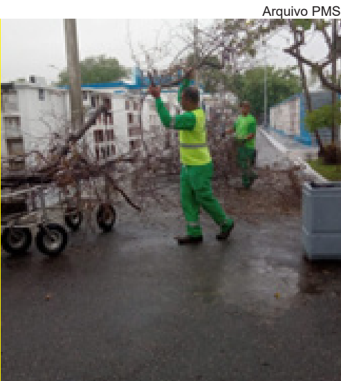
Cemitério da Areia Branca: prosseguem trabalhos de limpeza
