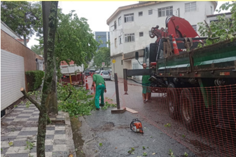
Remoção de vegetal é realizada na Rua Doutor Nilo Costa, no Macuco
