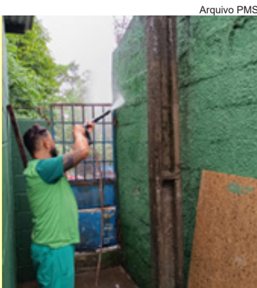
Lavagem de estruturas no Chapadão do Cruzeiro
