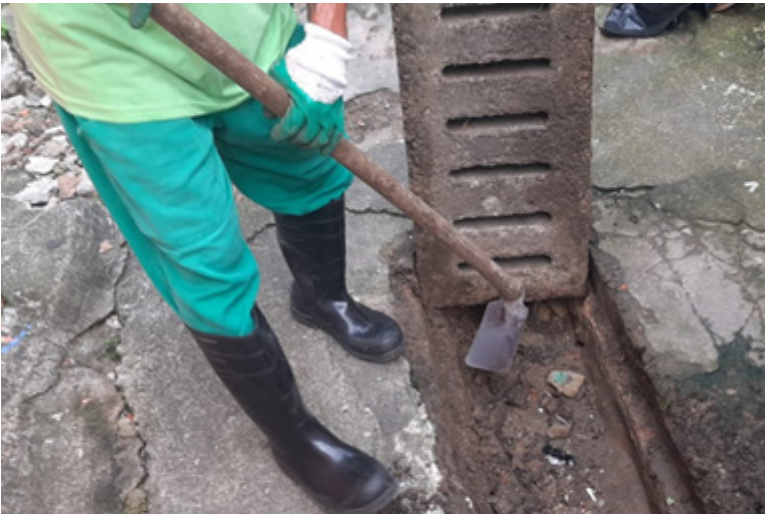
Realizada limpeza de grelhas Rua 9, no Morro Penha
