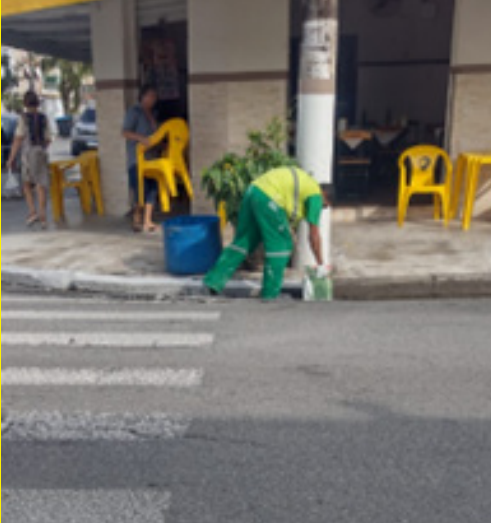
Caiação de postes e guias nas vias Clemente Pereira e Evaristo da Veiga
