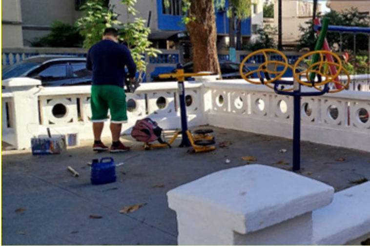
Aparecida: seguem reparos na Praça Waldemar Canelas
