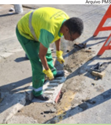
Conversão de “boca de sapo” para “boca de lobo” na rua Frei Vital
