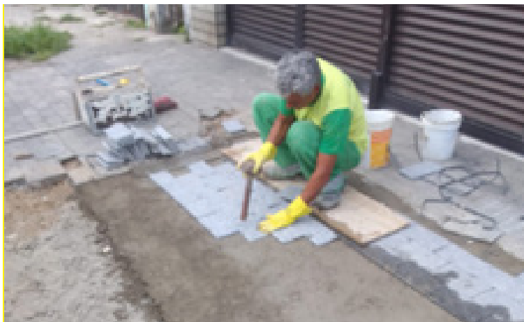
Reparo na calçada danificada pelas raízes de árvore na Rua Saturnino de Brito, Marapé
