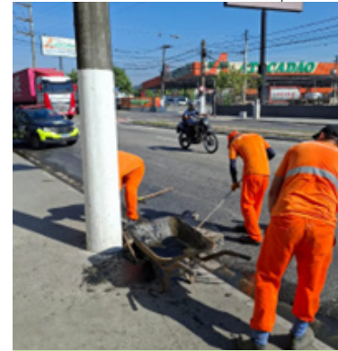
Limpeza no sistema de drenagem da avenida Nossa Senhora de Fátima
