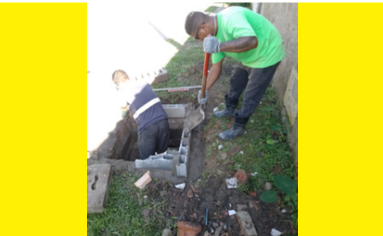
Reparo em caixa de passagem na Rua Maria das Graças, no Caruara
