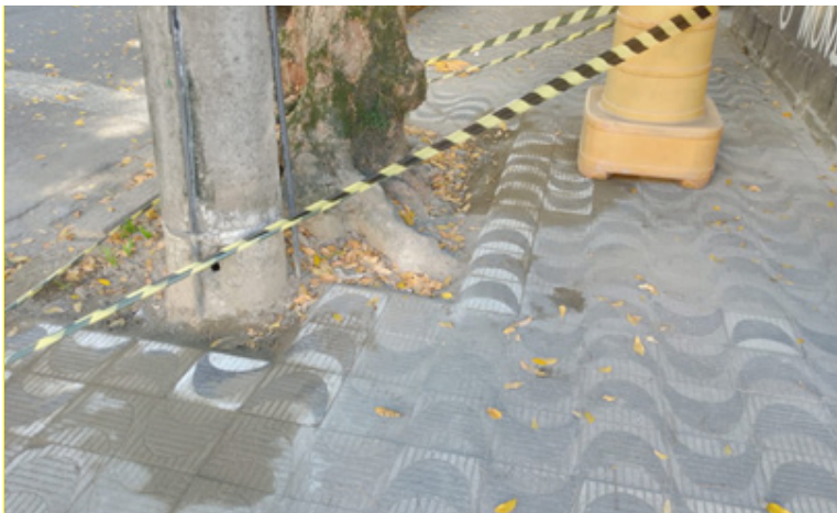
Reparos em calçada tipo Copacabana, na Rua Bahia, em frente ao 49, no Gonzaga
