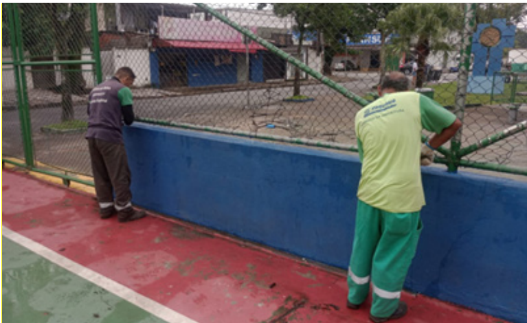
Troca de telas danificadas da quadra da Praça Prestes Maia
