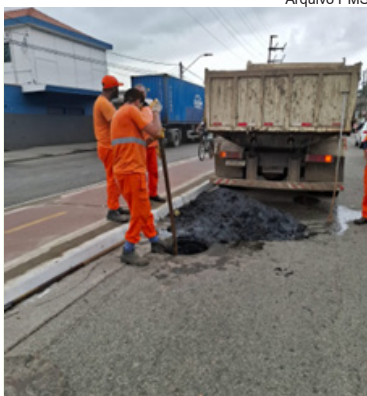
Limpeza de drenagem da Avenida Nossa Senhora de Fátima
