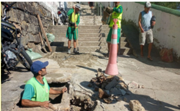
Manutenção em caixa de passagem e fechamento de abastecimento no Monte Serrat
