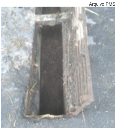
Limpeza e manutenção de grelhas Rua São Domingos
