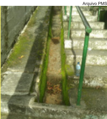
Limpeza de grelhas e canaletas no São Bento
