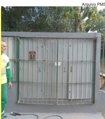
Portão soldado na Lagoa da Saudade, serviço equipe da Ecofábrica
