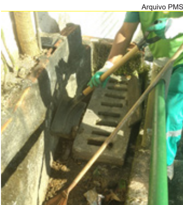
Limpeza de grelhas na Rua São Manoel, no Morro São Bento
