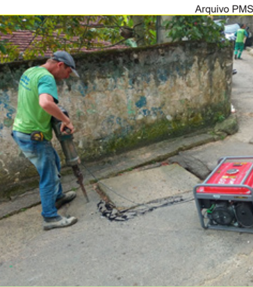
Manutenção em grelhas e levantamento de tampa no São Bento
