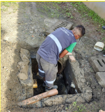
Troca de manilhas e reparo em caixa de passagem no Caruara
