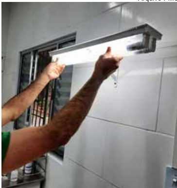
Instalação de uma luminária na clínica veterinária no Monte Cabrão
