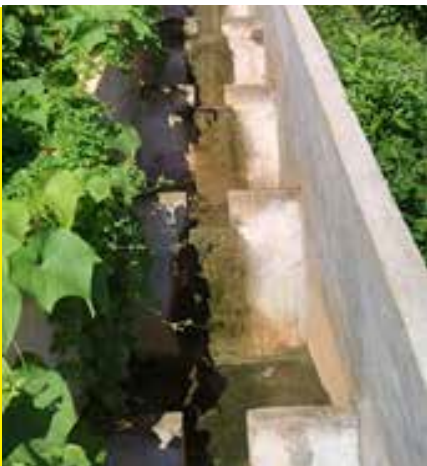
Limpeza de caixa de drenagem e escada hidráulica no Complexo Marina Magalhães
