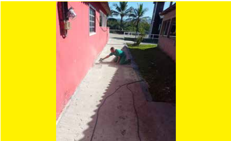
Colocação de juntas de dilatação no concreto dos caminhos da Ilha Diana
