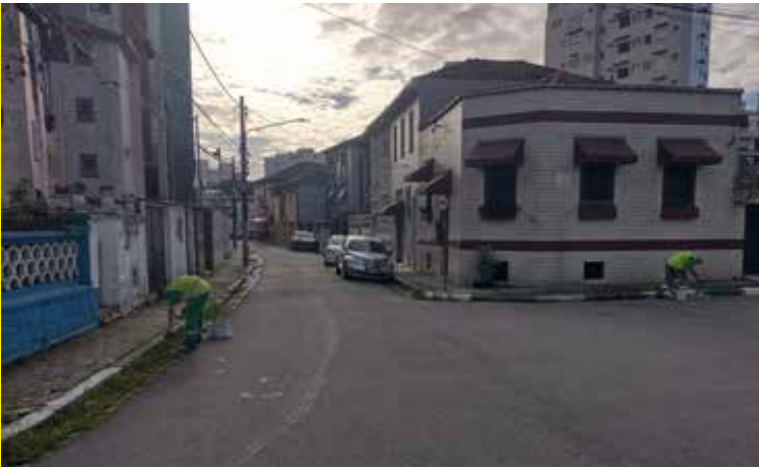
Caiação de guias e postes em diversas nas ruas e praça na Vila Belmiro
