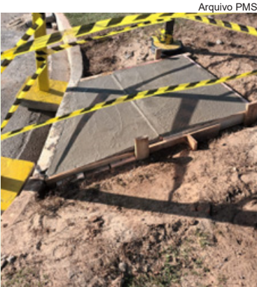
Confecção de tampa de concreto no Emissário Submarino
