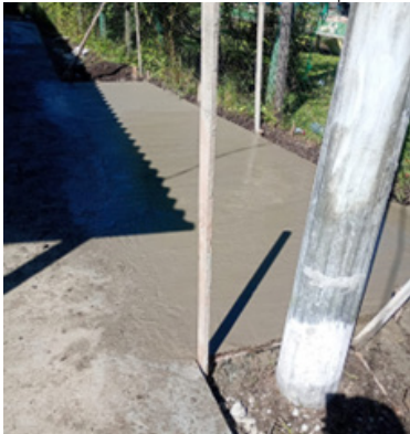
Manutenção e concretagem no Caminho na Ilha Diana
