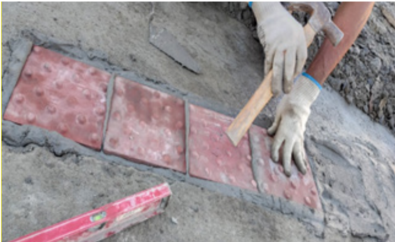
Instalação de piso tátil na Rua Andrade Soares, no Caruara
