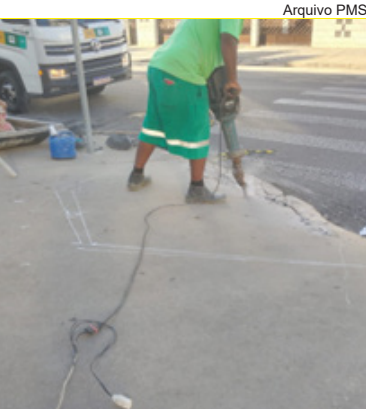
Construção de rampas de acessibilidade no Marapé
