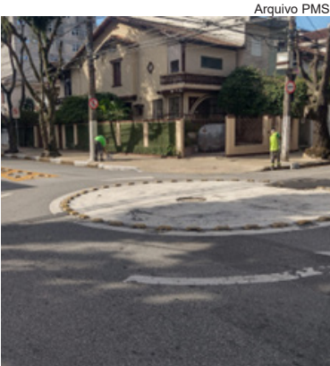
Caiação de guias e postes de toda extensão da Rua São Paulo
