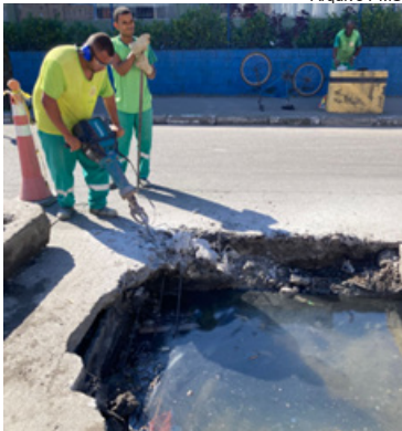
Reparo em parede para instalação de tampas de concreto no Chico de Paula
