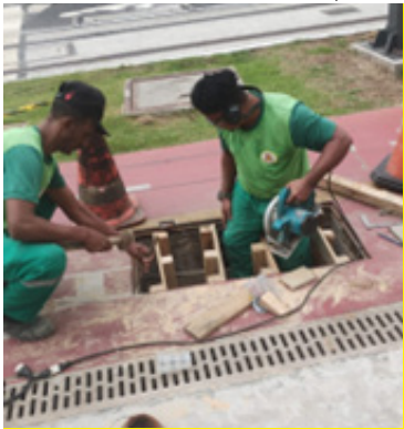
Caixa de passagem na ciclovia (São Leopoldo com S.Bento) é fechada
