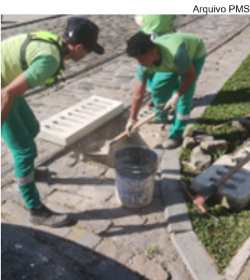
Troca de grelha na esquina das ruas Tuiuti com Frei Gaspar
