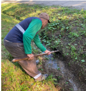
Manutenção e limpeza de vala na Rua Tupi, no Caruara
