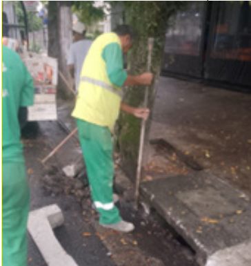
Troca de meio-fio na Avenida dos Bancários, 40, na Ponta da Praia
