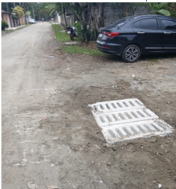
Substituição de boca de lobo na Rua Três, no Caruara
