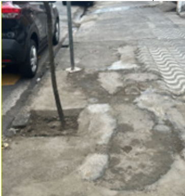
Reparo em calçada e abertura de berço na Rua Manoel Tourinho
