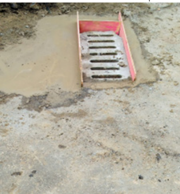
Instalação de boca de lobo na Rua Rosário do Nascimento
