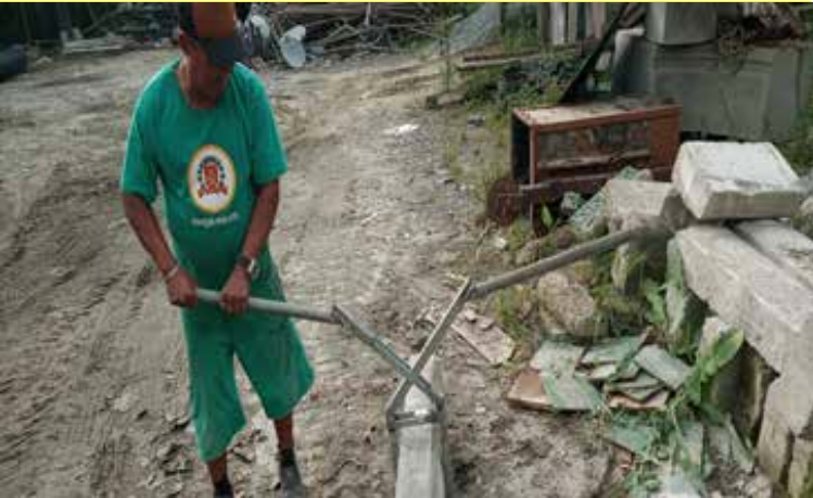
Confecção de ferramentas para instalação de guias
