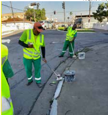
Rua Domingos José ganha pintura de guias e postes
