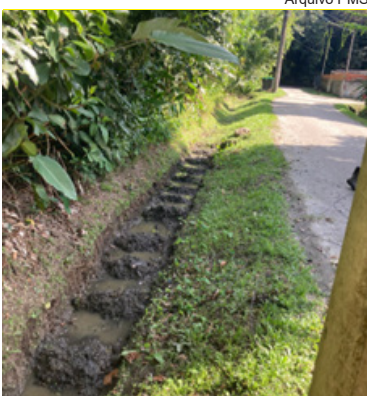
Limpeza de vala na Rua Tamoio, no Caruara
