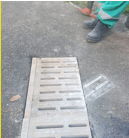
Troca de grelha na calçada na Rua Prudente de Moraes
