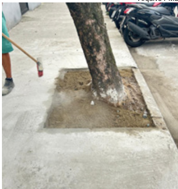
Abertura de berço para árvore na cova na Av. Conselheiro Alves
