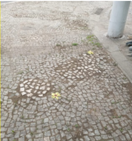
Reposição de mosaico na Avenida São Francisco, frente Banco Safra
