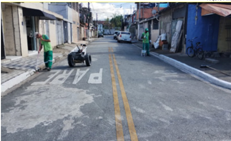
Pintura de guias e postes na Rua Mário Sérgio Oréfica, no Rádio Clube
