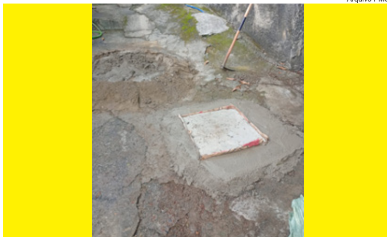
Recapeamento da rua e instalação de tampa na Rua 7, Morro Penha
