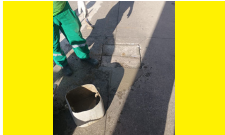
Nivelamento de tampa de caixa de passagem na Rua São Bento, 84
