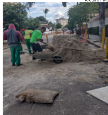
Reparos em ruas e calçadas na 28 de Setembro com Nilo Costa
