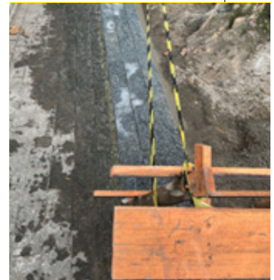
Reparo em calçada na Rua André Vidal de Negreiros, na Ponta da Praia
