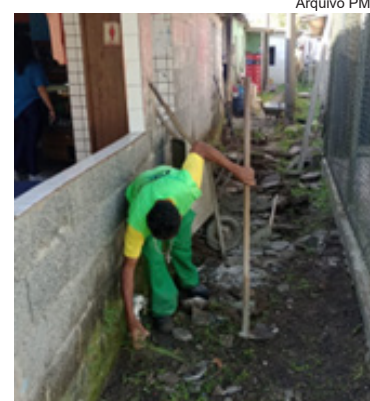
Nivelamento de aterro e retirada de entulho, na Ilha Diana
