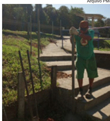
Instalação de tubos para corrimão no ponto de ônibus, no Caruara
