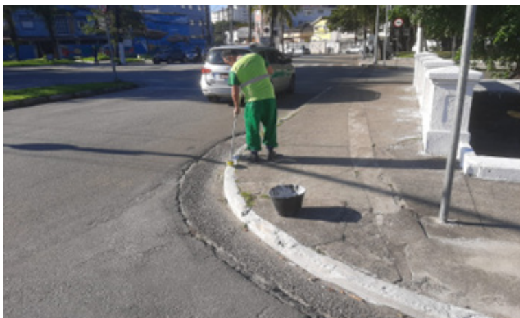
Pintura em postes, mureta e na cabeceira do Canal 1
