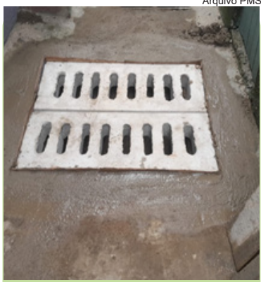
Construção de caixa de captação com instalação de rede de drenagem
