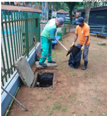
Limpeza de caixas de sopé e canaletas na Lagoa da Saudade
