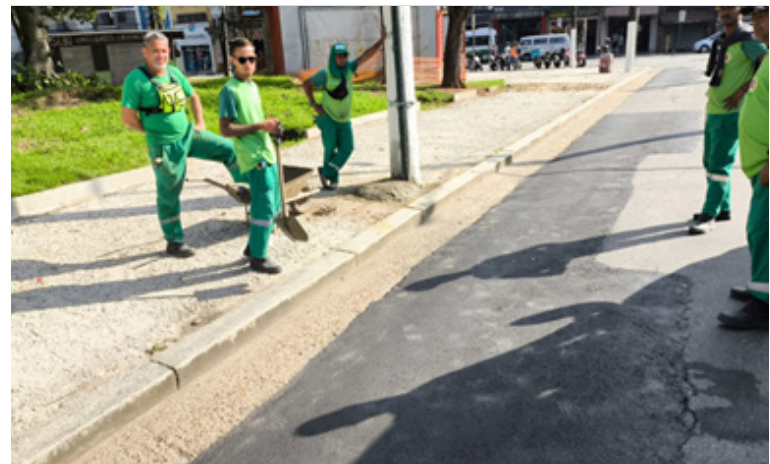
Concretagem de caixa de passagem elétrica na Praça José Bonifácio
