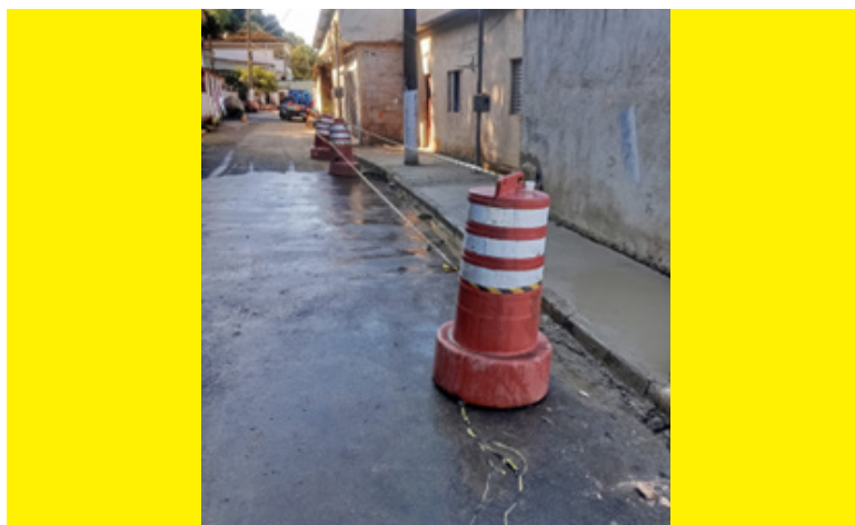
Concretagem de calçada na Praça Manoel Celestino, no Monte Cabrão
