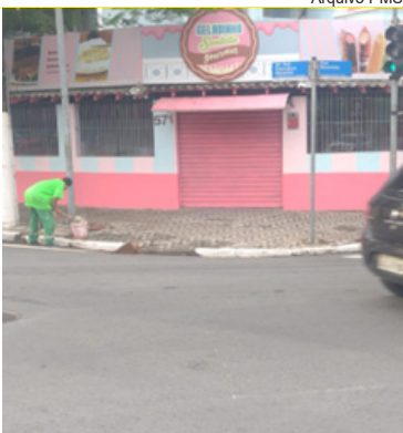
Pintura de postes e guias na Rua Maranhão e da Av. Francisco Glicério
