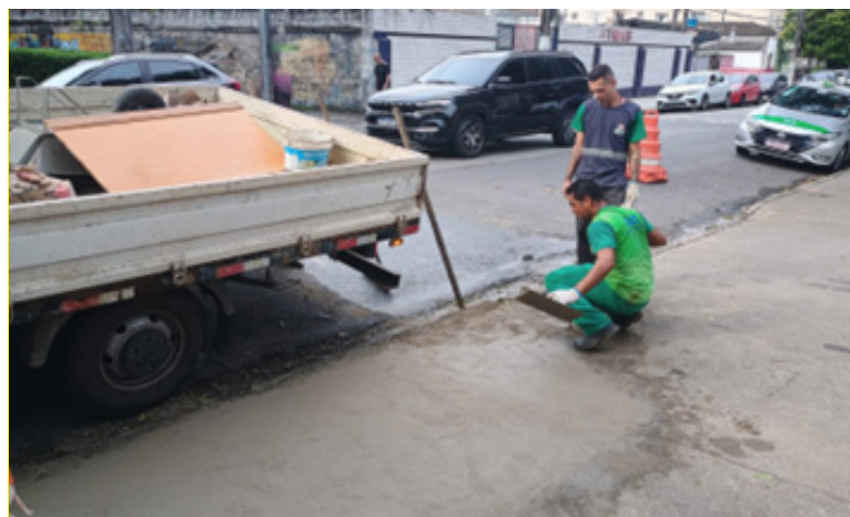
Manutenção com cimento na calçada da Rua São Paulo, 40
