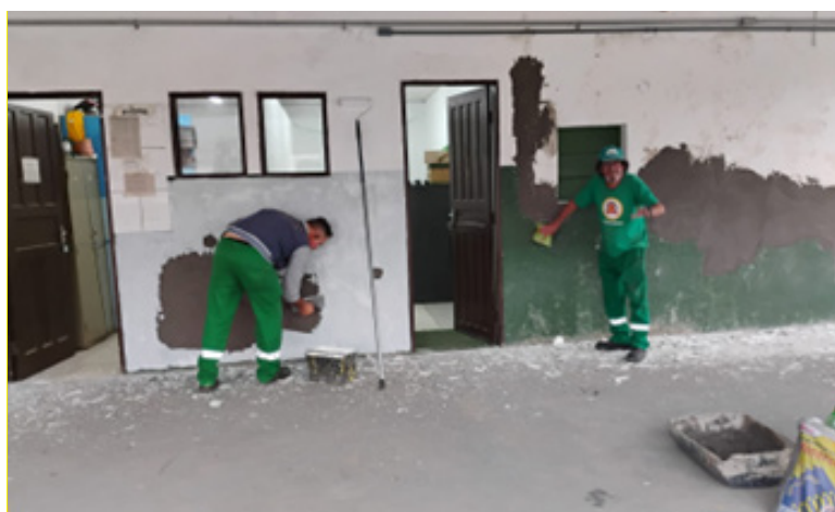
Preparação para pintura da parede da Cortec
