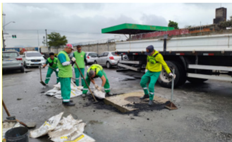
Troca de laje do posto de visita na Rua Aguiar de Andrade com General Câmara
