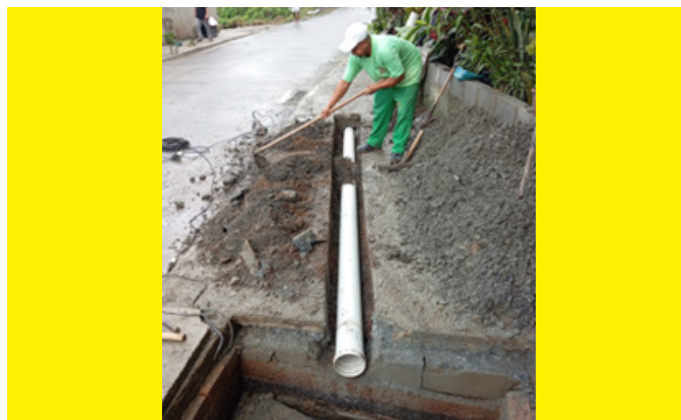
Instalação de tubo para passagem de água no no Monte Cabrão
