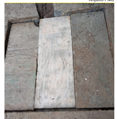
Tampas para concretagem em praça do Monte Cabrão
