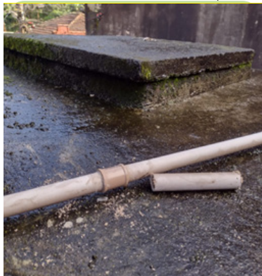
Conserto de tubulação com vazamento de caixa d'água
