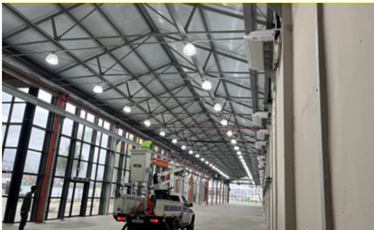
Troca de lâmpadas no Armazém 4, do Parque Valongo
