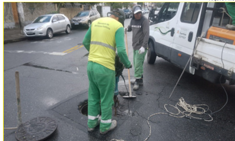
Nivelamento de posto de visita na esquina da Delfino Stockler com Reinaldo Porchat
