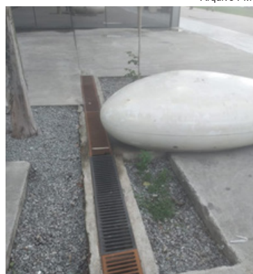
Substituição de grelha no Parque Valongo
