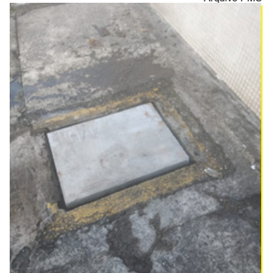
Troca de tampa de caixa de incêndio na Rua Andrade Neves
