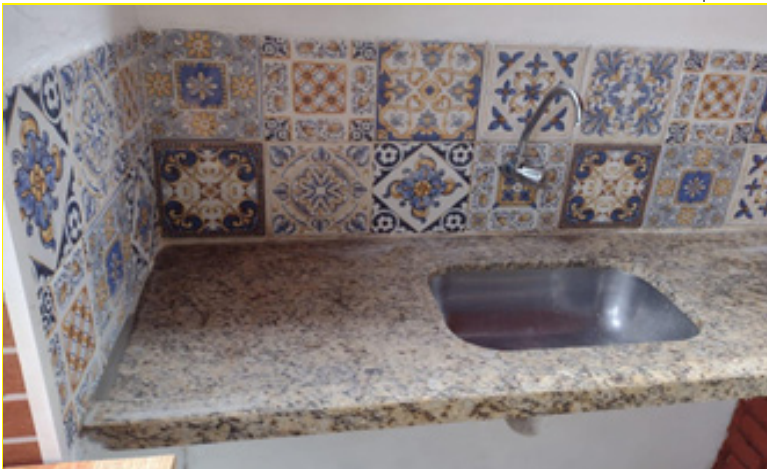
Fixação de bacia sanitária e rejunte de pia do quiosque 03 (Vila Criativa), Nova Cintra
