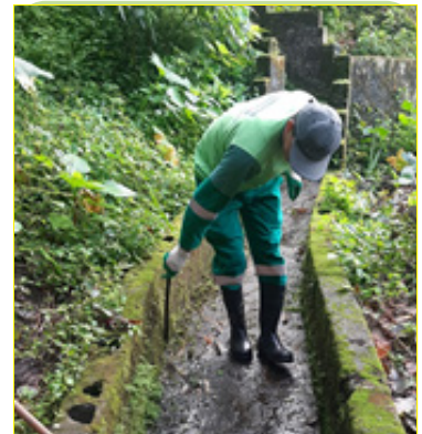
Limpeza de caixas de sopé e escada hidráulica no José Menino
