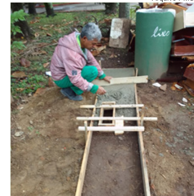
Alexandre Martins: concretagem para fixação das peças do totem em praça
