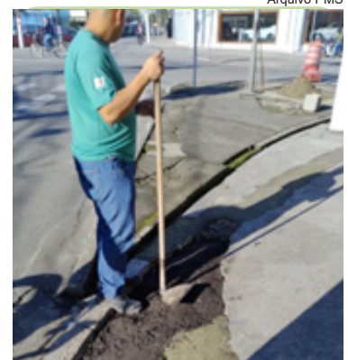
Manutenção na calçada da Av. Rangel Pestana x Rua Brás Cubas
