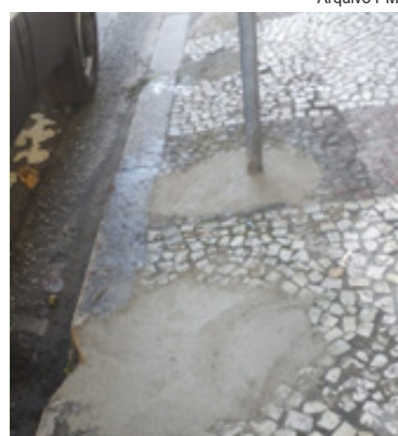
Tapamento de buraco com massa na calçada da São Francisco, 137
