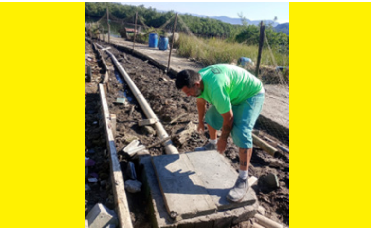
Serviços de concretagem de caminhos na Ilha Diana
