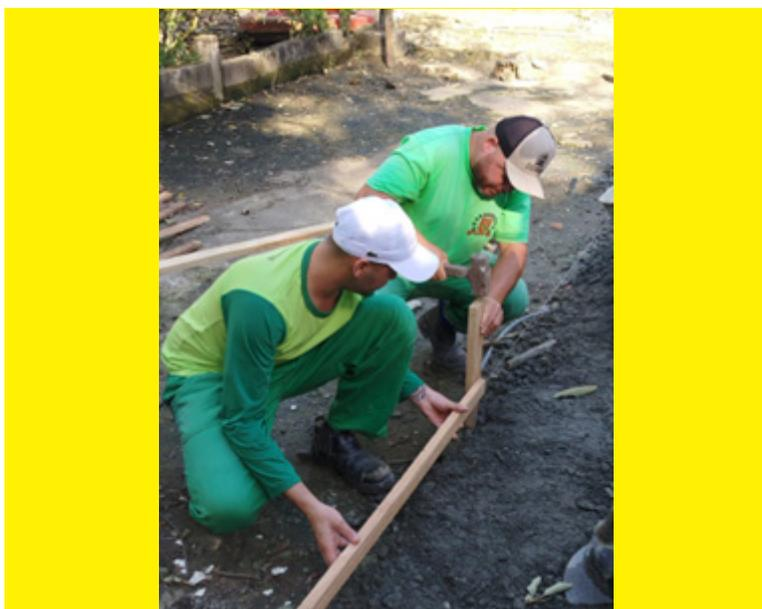
Instalação de sarrafos e nivelamento de área com bica corrida, no Monte Cabrão
