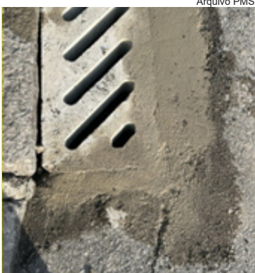
Troca de boca de lobo na esquina da Washington Luiz x Rodrigues Alves
