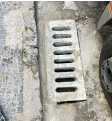
Troca de boca de lobo na Avenida Ana Costa, em frente ao nº 518
