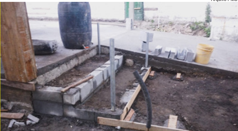
Confecção dos degraus da escada da serralheria
