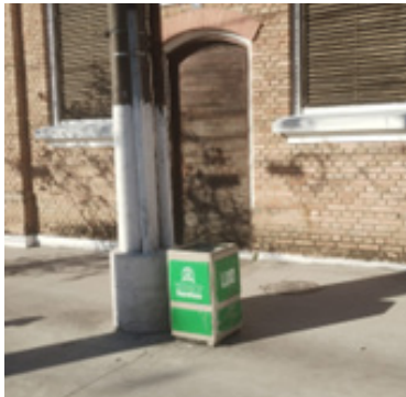
Colocação de lixeira na área do Poupatempo
