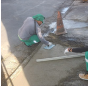
Reparo de calçada na Rua General Câmara, 509
