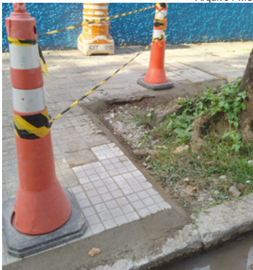
Reparos na calçada da UME. Leonor Mendes de Barros, Gonzaga
