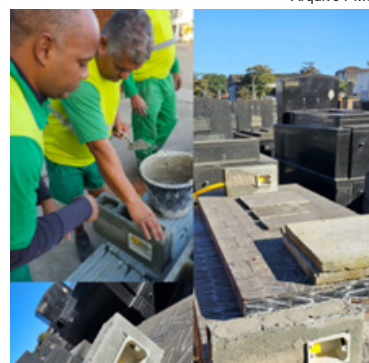
Construção das novas tomadas das alamedas do Cemitério Paquetá
