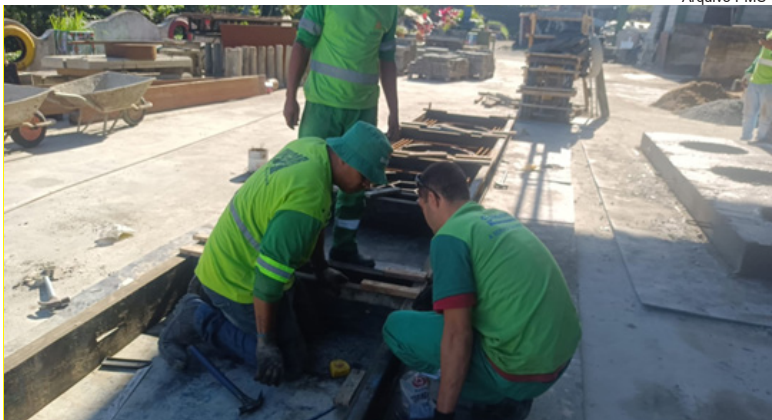
Montagem das formas dos poços de visita
