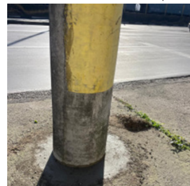
Manutenção na calçada na Rua Xavier Silveira, Paquetá
