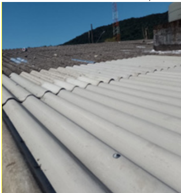
Manutenção do telhado da Sociedade Esportiva Caruara
