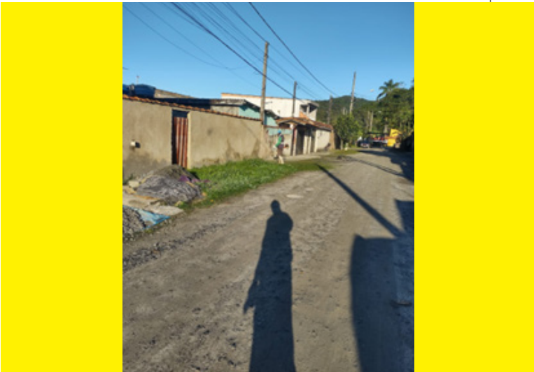
Serviços de roçada e limpeza na Rua Trusilva, Caruara
