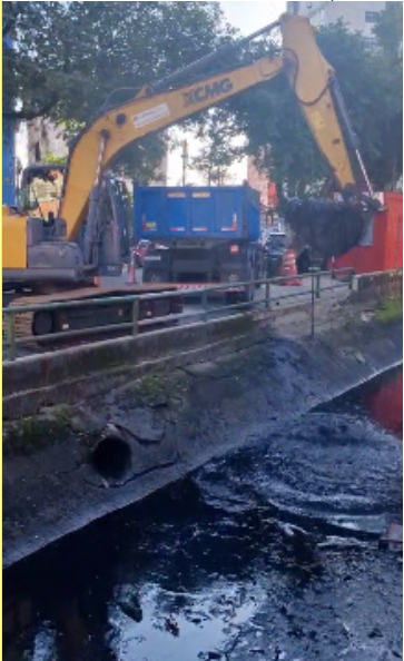
Desassoreamento mecânico no canal Vivaldo de Almeida Nery, no Saboó
