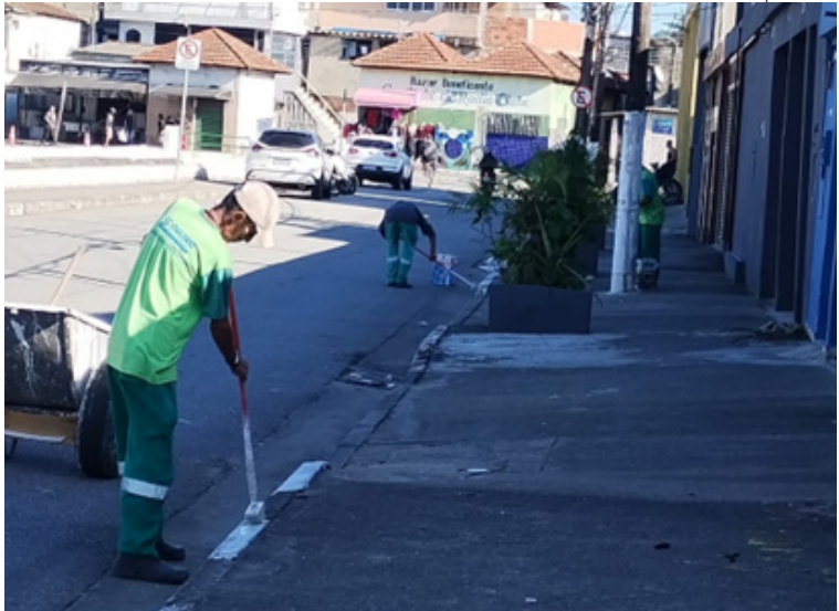
Pintura de guias e postes nas ruas Romeu La Scala, Edilson Paes Melo e Hugo Maia
