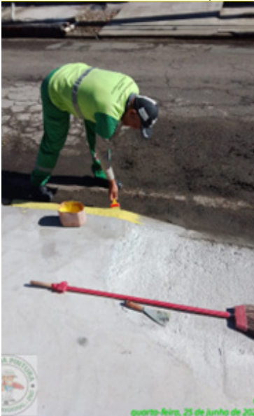
Pintura de rampas na Rua Nilo Rodrigues Paz, Rádio Clube
