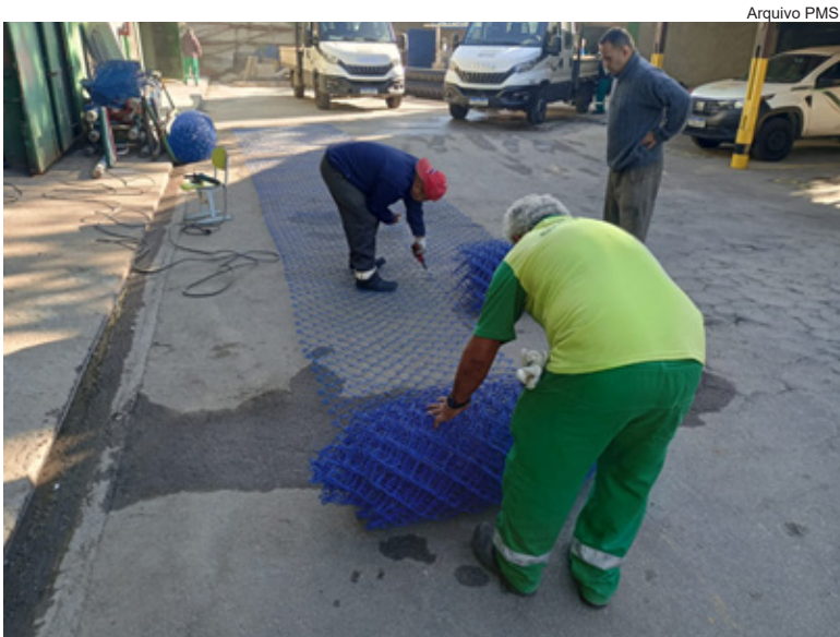
Corte de tela de para colocação no playground ao lado da SM do Piratininga
