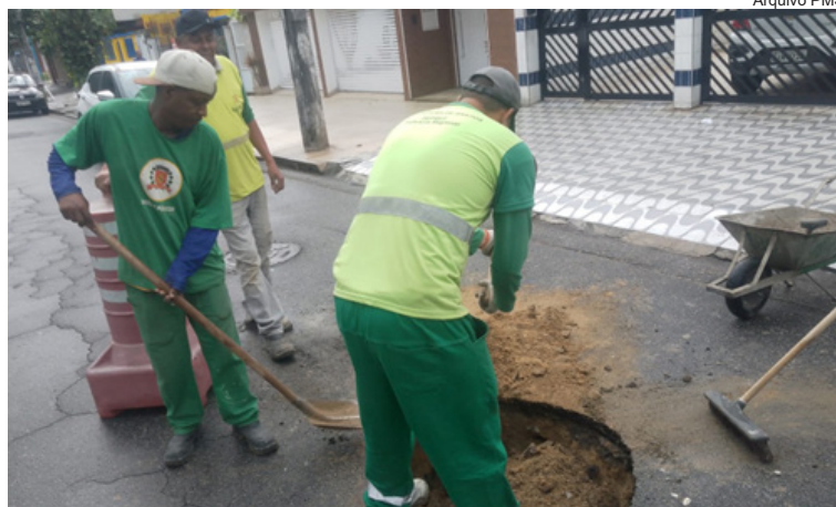
Manutenção asfáltica na Rua Benjamin Constant, em frente ao nº 195
