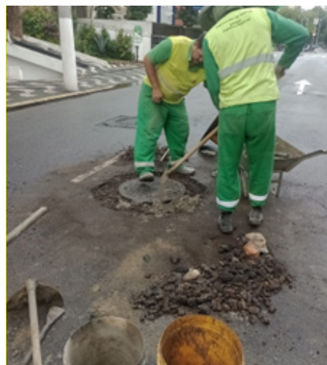
Serviços de reposição de poço de visita na Av. Epitácio Pessoa com Rua Ricardo Pinto
