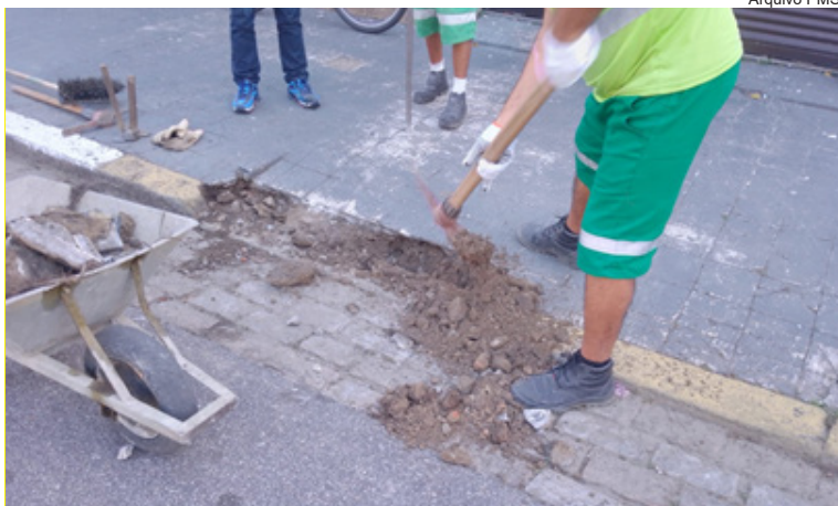
Renivelamento de sarjeta e meio-fio na Rua Teixeira de Freitas
