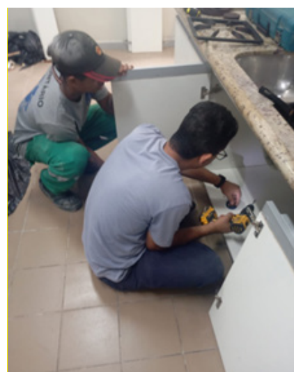
Instalação dos armários na cozinha da Vila Criativa, na Vila Progresso
