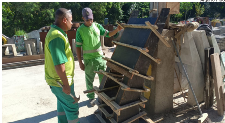
Travamento da forma do pedestal dos comedouros dos pássaros
