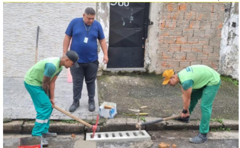
Substituição de boca de lobo e reconstrução e limpeza de caixa na R. Ângelo Martins Melero
