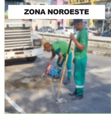
Troca de boca de lobo, instalação de meio-fio, restauro e limpeza de caixa
