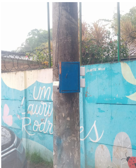
Instalação de caixa de luz na Lagoa da Saudade, Nova Cintra
