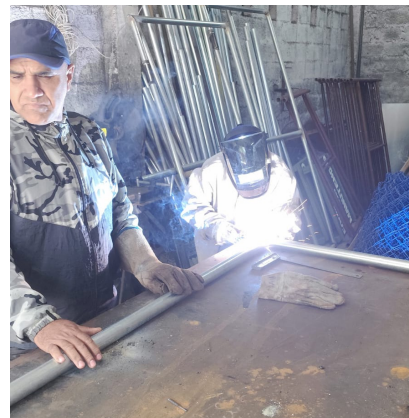
Confecção de portões para instalação na quadra esportiva na Rua Nicolau Geraigire, no São Manoel
